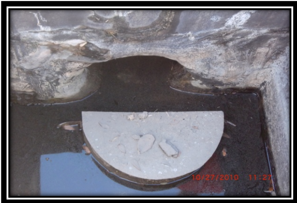
Loose Pollution Retardant Baffles
